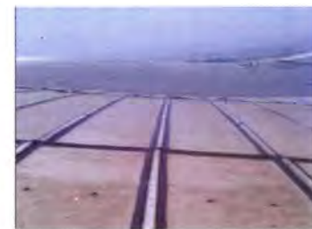
阳光屋顶 PC 罩防水工程
