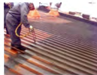
彩钢板屋面防水工程
