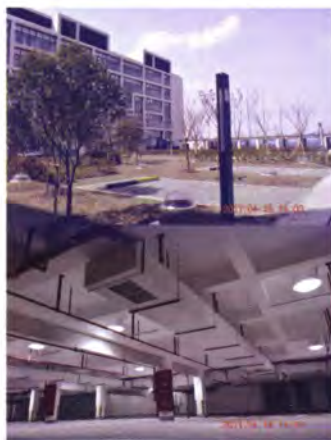
上海电气地下车库
