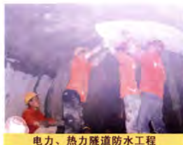
电力、热力隧道防水工程
