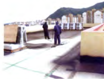
混凝土屋面防水工程
