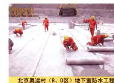
北京奥运村（B、D区）地下室防水工程
