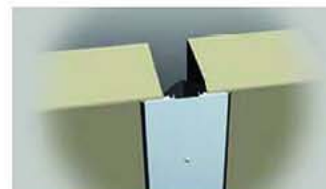
金属盖板型内墙变形缝装置
